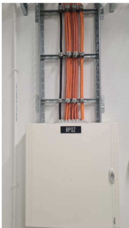
Rozdzielnice elektryczne obiektowe – przykładowy sposób montażu:
