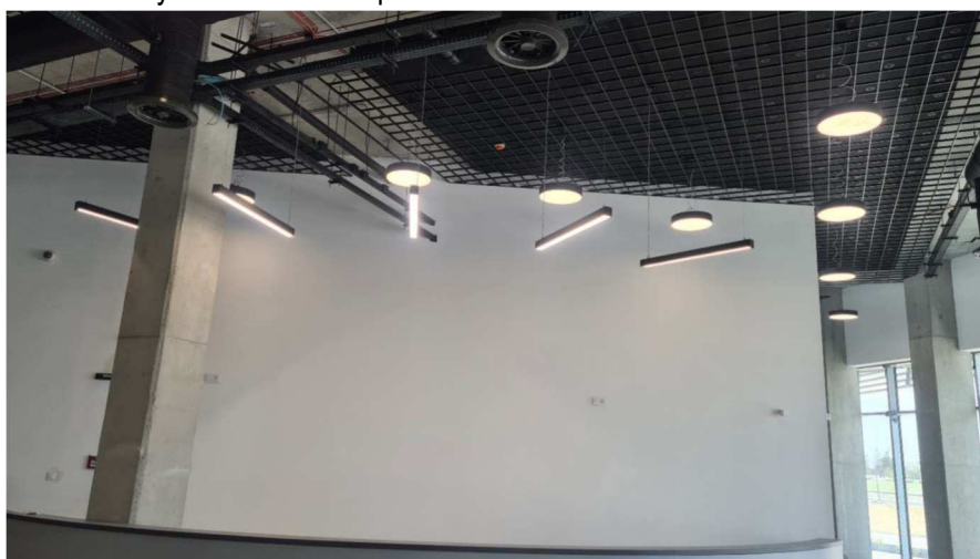
Montaż opraw oświetlenia podstawowego w strefie wejściowej kas biletowych – sterowanie za pomocą łączników oświetleniowych zlokalizowanych na ścianie w pomieszczeniu kas:
