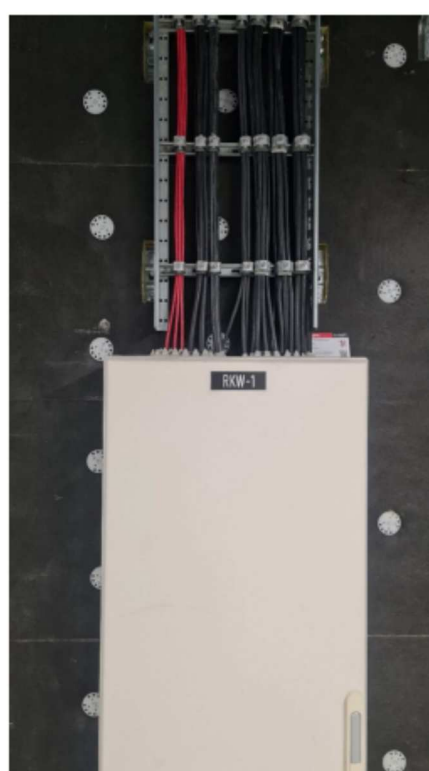
Rozdzielnice elektryczne obiektowe – przykładowy sposób montażu:
